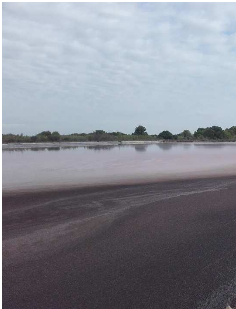
Traitement des effluents dans un bassin d'évaporation
